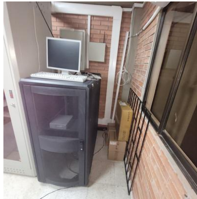
Fuente: Registro fotográfico tomado en la ORIP – cuarto de cómputo y estado del rack desorganizado, sin señalización.
