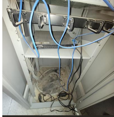
Fuente: Registro fotográfico tomado en la ORIP – cuarto de cómputo y estado del rack desorganizado, sin señalización.
