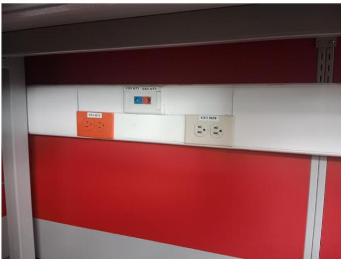
Recordar que un punto de red está compuesto por una toma para red de datos (rojo y azul en el centro), un tomacorriente de energía regulada (anaranjado) y una toma eléctrica no regulada (blanca)
